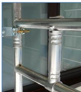
basso dell'elemento superiore. Congiunti i due elementi, ruotare il giunto fin quando l'attacco rapido dello stesso non si innesti nell'elemento sottostante (fig.4).
