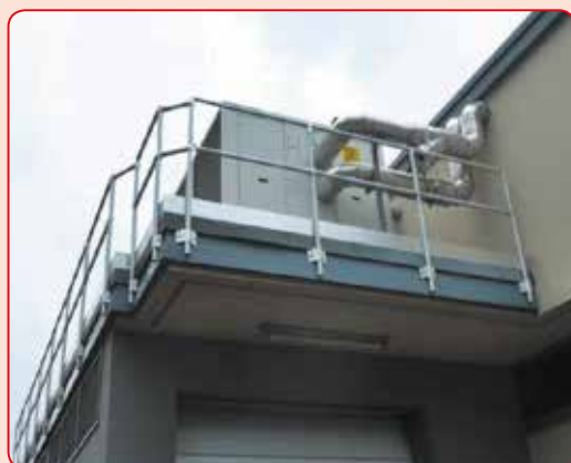
• Esempio di parapetto montato su edificio
