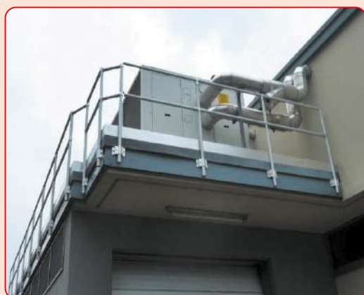
116 • Esempio di parapetto montato su edificio
