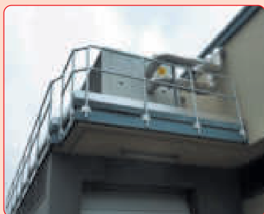
116 • Esempio di parapetto montato su edificio
