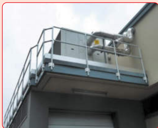
116 • Esempio di parapetto montato su edificio
